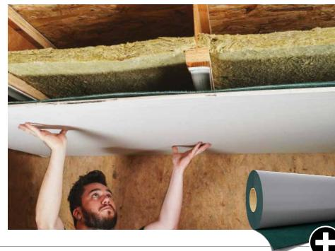
Den unteren Bereich der Decke schließen, indem auf die Sparren eine Dämmschicht **PIANO A**, **SILENT UNDERFLOOR**, **GEMINI**, **GIPS BAND**, **CONSTRUCTION SEALING** aufgebracht wird und der Gipskartonplatte mit **SILENT WALL BYTUM** oder **SILENT WALL BYTUM SA** Masse hinzugefügt wird
