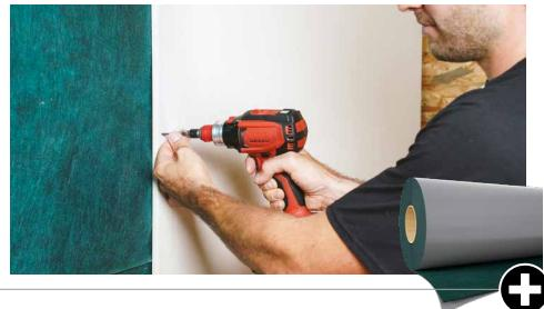
Hinzufügen von Masse durch Kopplung von **SILENT WALL BYTUM** oder **SILENT WALL BYTUM SA** mit der Gipskartonplatte
