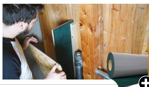
Einen technischen Hohlraum erstellen und **SILENT WALL BYTUM** oder **SILENT WALL BYTUM SA** verwenden, um die Schalldämmung zu verbessern
